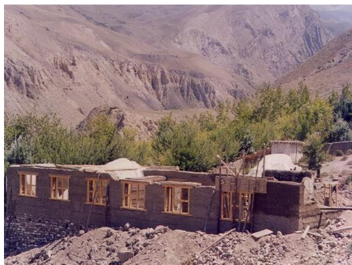
La nouvelle école en construction
