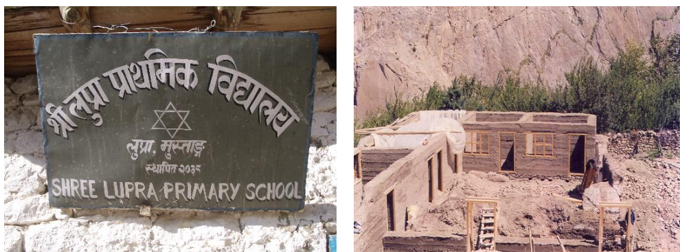
Un chantier à près de 3000 m d'altitude
